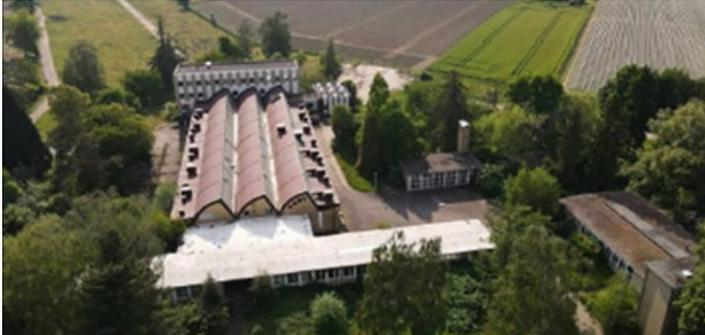
Die Fotografie zeigt in der Mitte den „Sendersaal“ als hochmodernen Baukörper mit dem auffallenden „Sheddach“, das einen optimalen Lichteinfall ermöglichen und dazu eine mögliche Erweiterung erleichtern sollte. (Foto: Guido Jansen)
