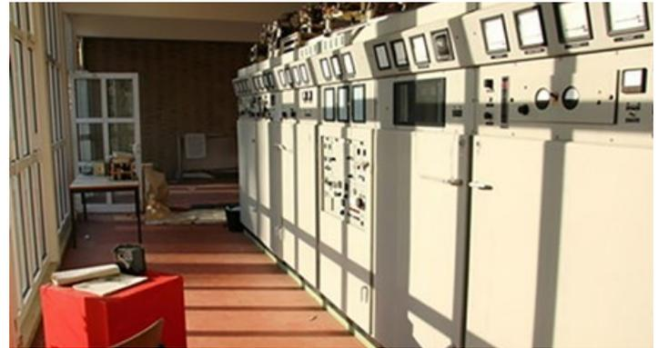
Bereits in den 1980er-Jahren, nach der Modernisierung der Anlagentechnik, lagerten Mitarbeiter einen kompletten handbedienten Sender aus den 1950er-Jahren – Telefunken Sender 1 – in ihrer Freizeit in das ehemalige Heizhaus der Anlage aus und bauten ihn dort funktionsfähig zu Demonstrationszwecken wieder auf.
